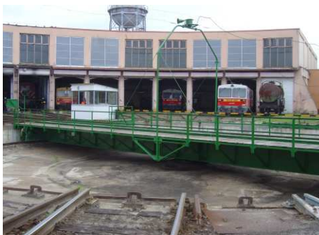
Mozdonyfordító-korong felújítása
