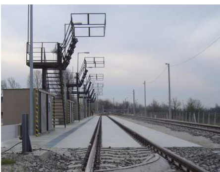
Vasúti olajlefejtő tálcá vágányépítés
