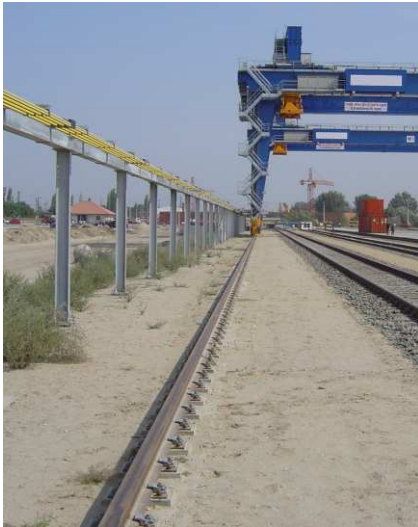
760 m darupálya építése és áramellátás építése BILK Kombiterminál Kft., Budapest
