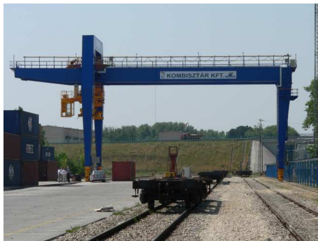
Daru áttelepítés és 360 m darupálya építés, Székesfehérvár
