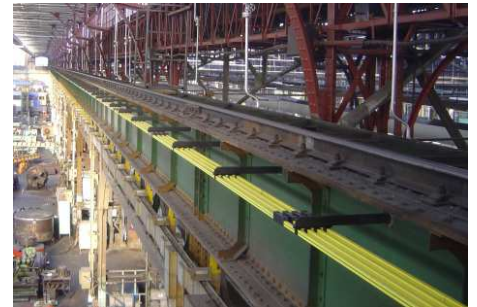
200 m zárt pályamenti áramellátás építése
