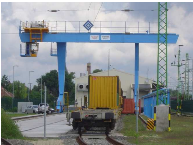
Rakományigazító terminál építése, Kelebia
