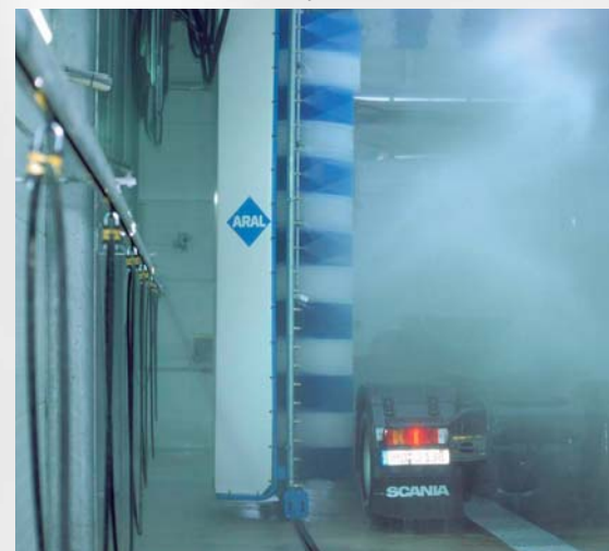
Kábelkocsi rendszer nedves környezetben
